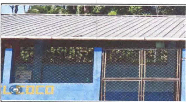
Foto 6: Reparación de canales para agua pluvial de PVC.
