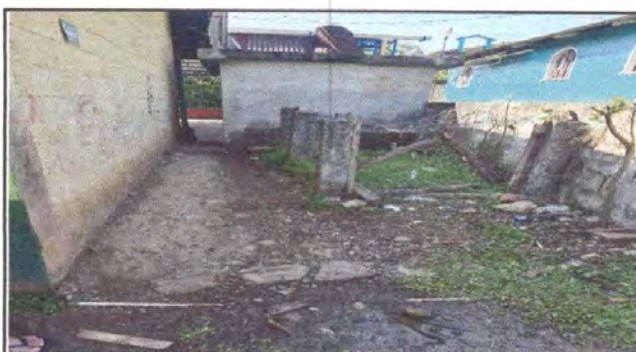
Foto 4: Sustitución piso torta de concreto.
