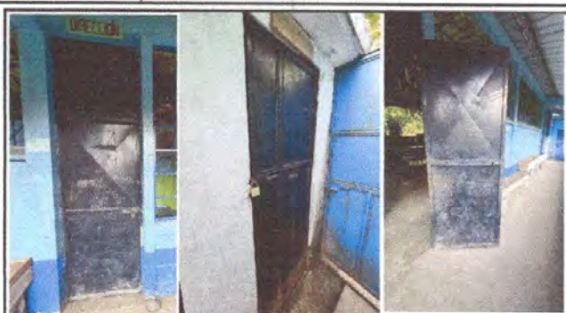
Foto 2: Mantenimiento a puertas.
