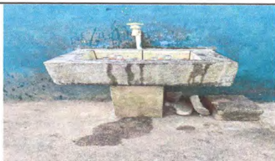
Foto 11: Sustitución de pila.
