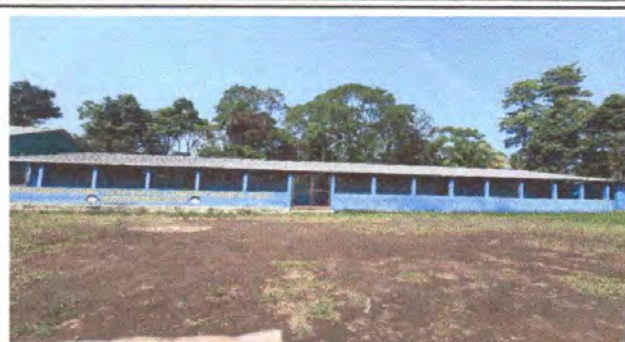
Foto 7: Pintura en muros exteriores e interiores.
