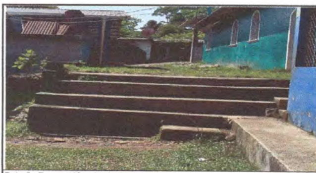
Foto 5: Reparación piso torta de concreto.
