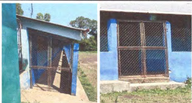
Foto 9: Reparación de portones.
